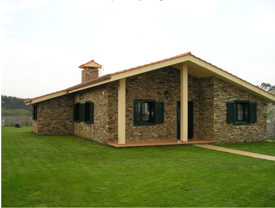
Vivienda unifamiliar de planta baja. Lugar de Monete. Valdoviño.
