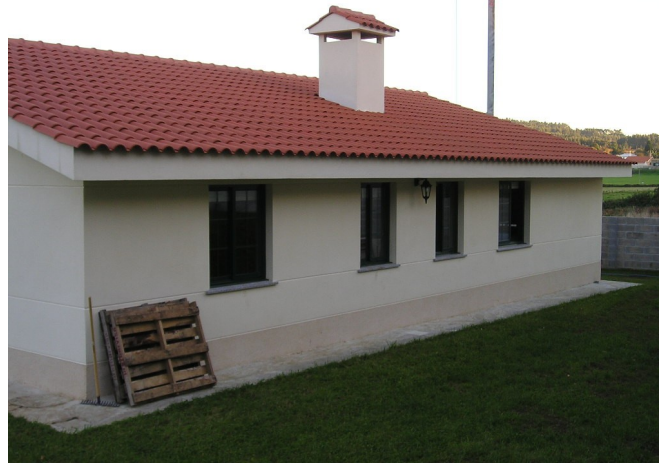
Vivienda unifamiliar de planta baja. Lugar de O Casal. Valdoviño. Vivienda 4.
